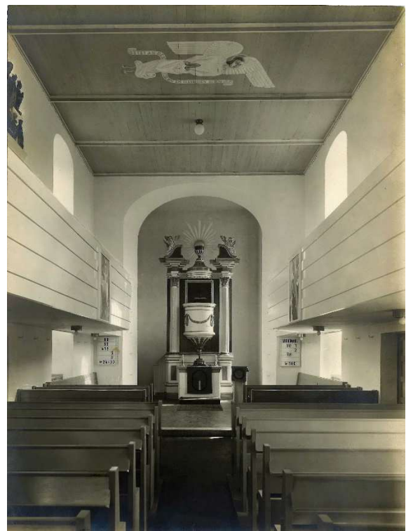
Bild 18: Blick zum Altar nach Umbau 1929
