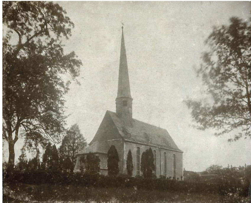
Bild 3: Kirche aus Südwesten vor Umbau 1929
