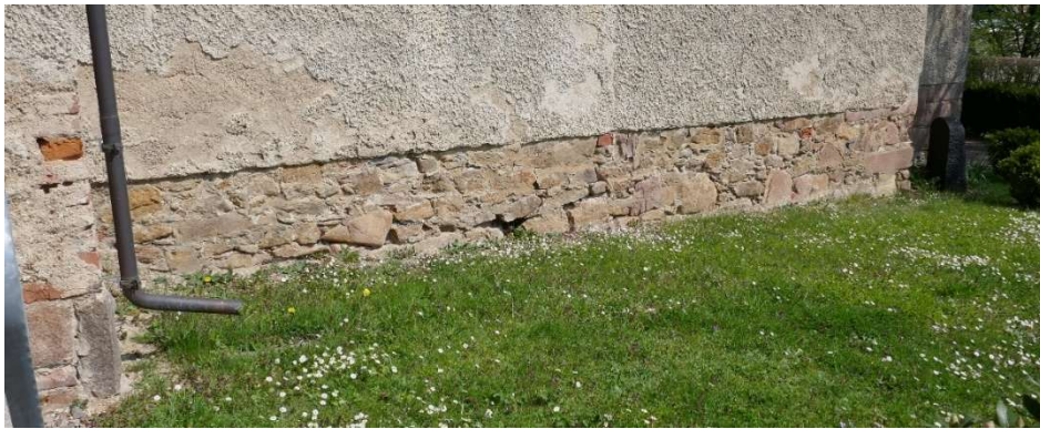
Bild 1: Grundmauer mit romanischen Resten
