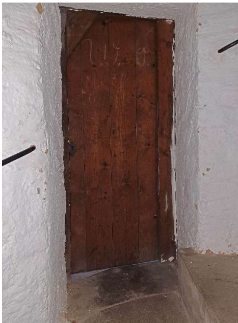
1. Dachboden über der Sakristei Engels
